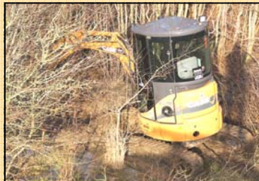
Gravemaskinen arbejder sig gennem både småtræer og rødder.
